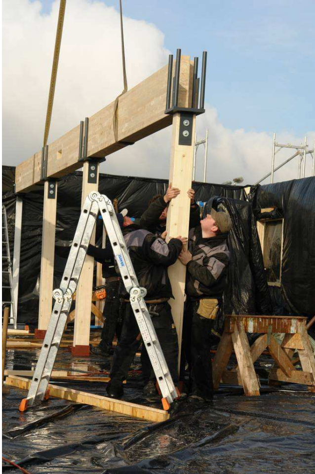
Beim Richten der Tragkonstruktion für die Decke des zweiten Obergeschosses
