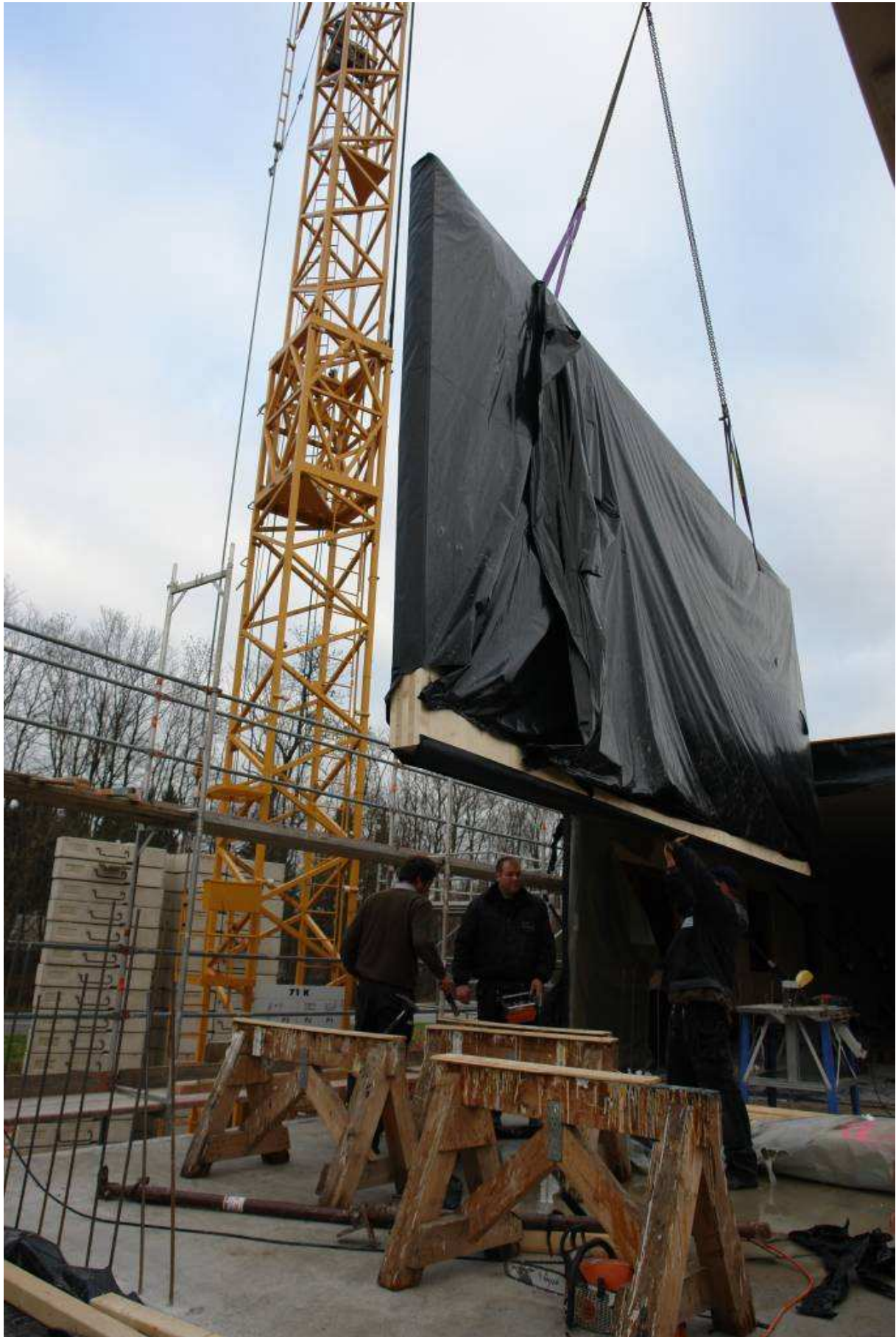
Montage der Brettsper Holz-Wandelemente im 2. OG
