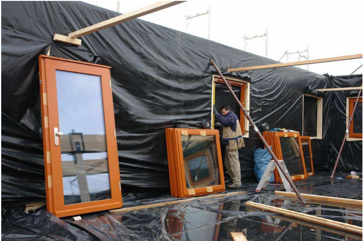
Die Fenstermontage erfolgt Zug um Zug mit der Montage de Wandelemente
