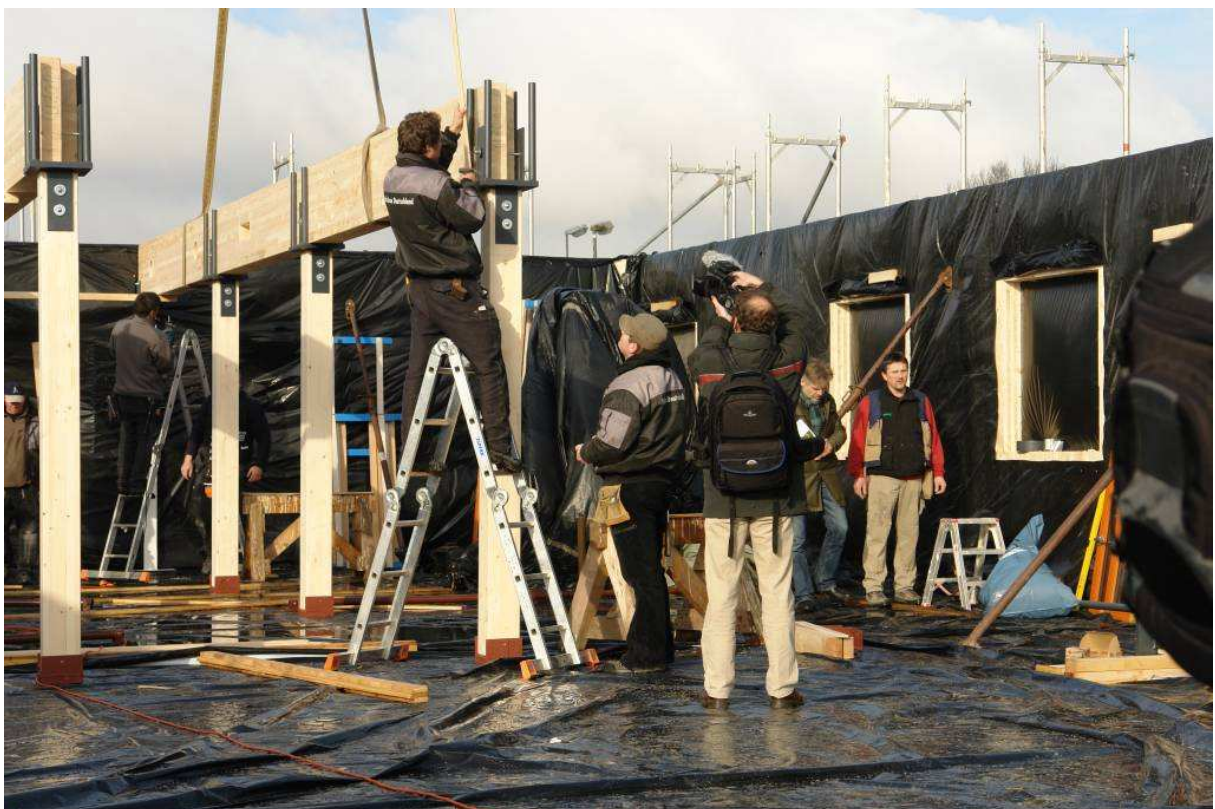
Richten der Tragkonstruktion des Decke des 2. OG
