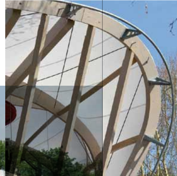
Dachkonstruktion Seilbahnstation: Membrandach auf Holz-Unterkon- struktion
