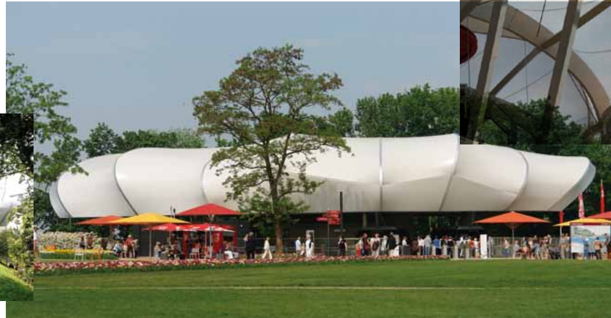
Dachkonstruktion Seilbahnstation: Membrandach auf Holz-Unterkon- struktion
