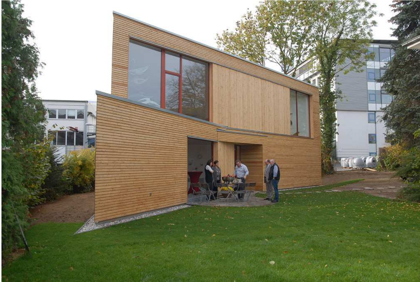
Das doppelstöckige Ateliergebäude ist ein Massivbau aus Brettsperrholzelementen [Eugen Decker Holzindustrie KG, Morbach]. Die ausgefrästen Öffnungen für Fenster und Türen wurden für den Innenausbau weiter verwendet.
