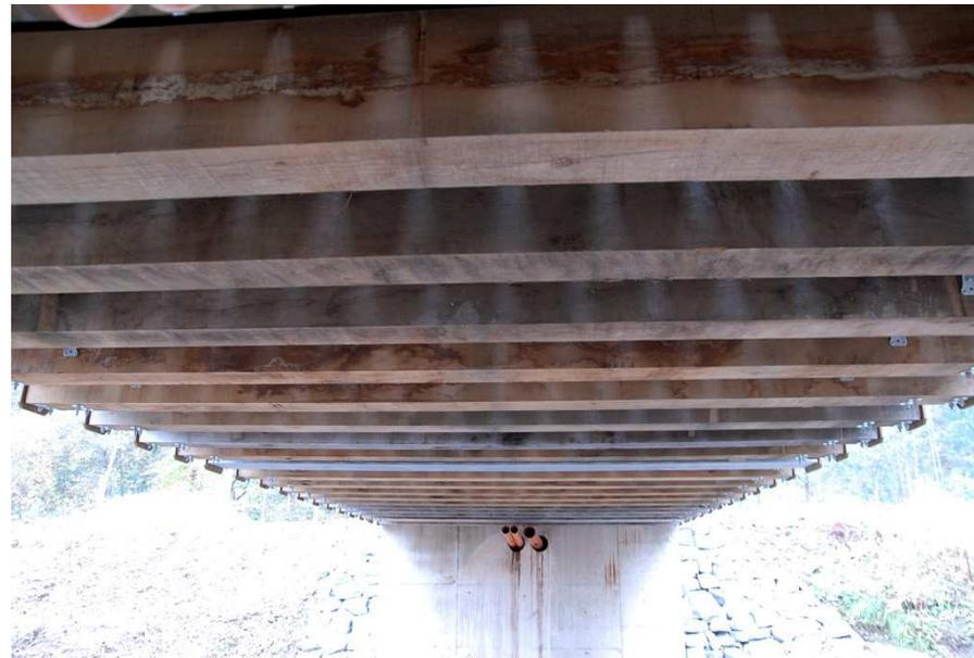
**Untersicht der Brücke: Das Sekundärtragwerk besteht aus Eichenquerbalken.**
