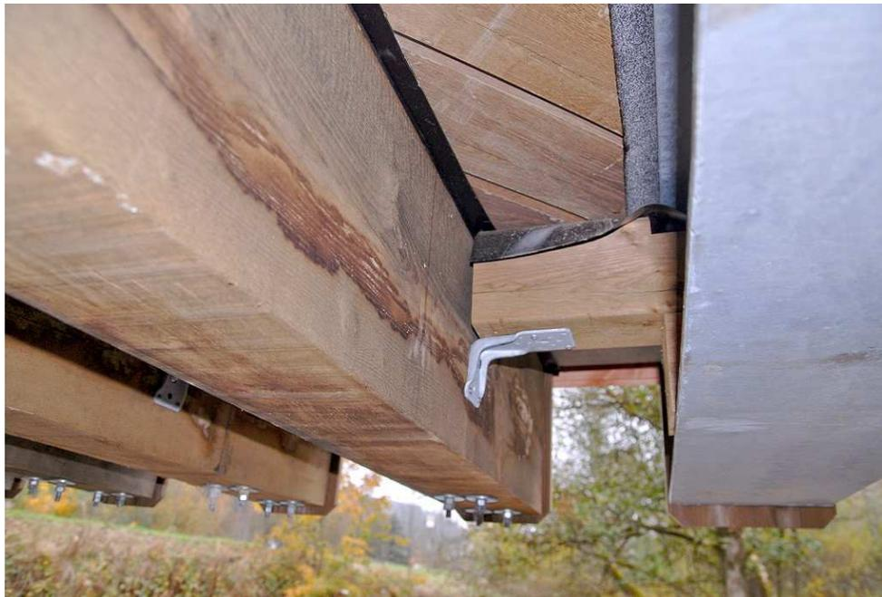
**Alle Holzbauteile sind auf Lücke gesetzt und oberseits durch eine Dichtungsbahn gegen Nässe geschützt (konstruktiver Holzschutz).**
