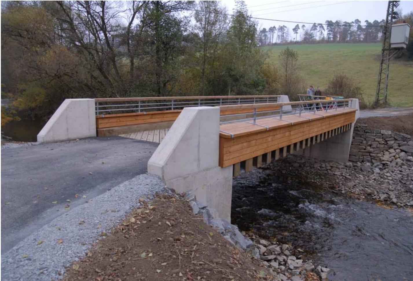
**Der Fahrbahnbelag aus Eichen-Riffelbohlen ist so konstruiert, dass einzelne Bohlen jederzeit ohne Probleme ausgetauscht werden können.**
