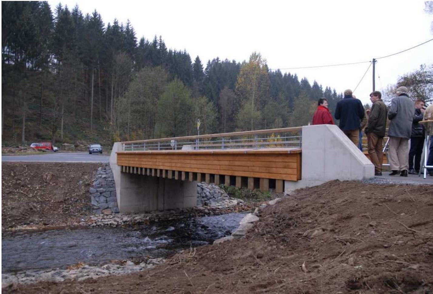
Die Hybridbrücke (Beton-Stahl-Holz) hat eine freie Spannweite von 12 m.
