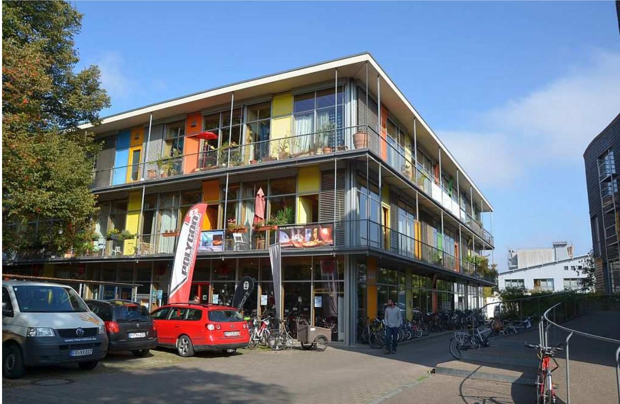
3. Bürogebäude „Amöbe“ ([www.mariecurie3.de](http://www.mariecurie3.de)): dreigeschossiger Bau, der seinen Namen von der ungewöhnlichen Grundrißform hat. Diese diente der maximalen Ausnutzung des schwierig geschnittenen Grundstücks. Betonkern mit verschindelter Holzfassade.
