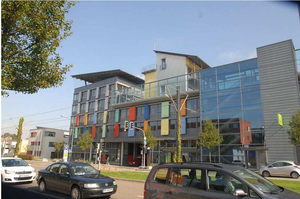
2. Gewerbegebäude an der Merzhauser Strasse: ein vorhandener, zweigeschossiger Massivbau wurde entkernt, saniert und mit einer Holzkonstruktion aufgestockt. Auch die hoch wärmegeämmte Fassade basiert auf Holzelementen. Das Gebäude ist allerdings äusserlich nicht als Holzbau zu erkennen ([www.lais-holzbau.de](http://www.lais-holzbau.de) ).
