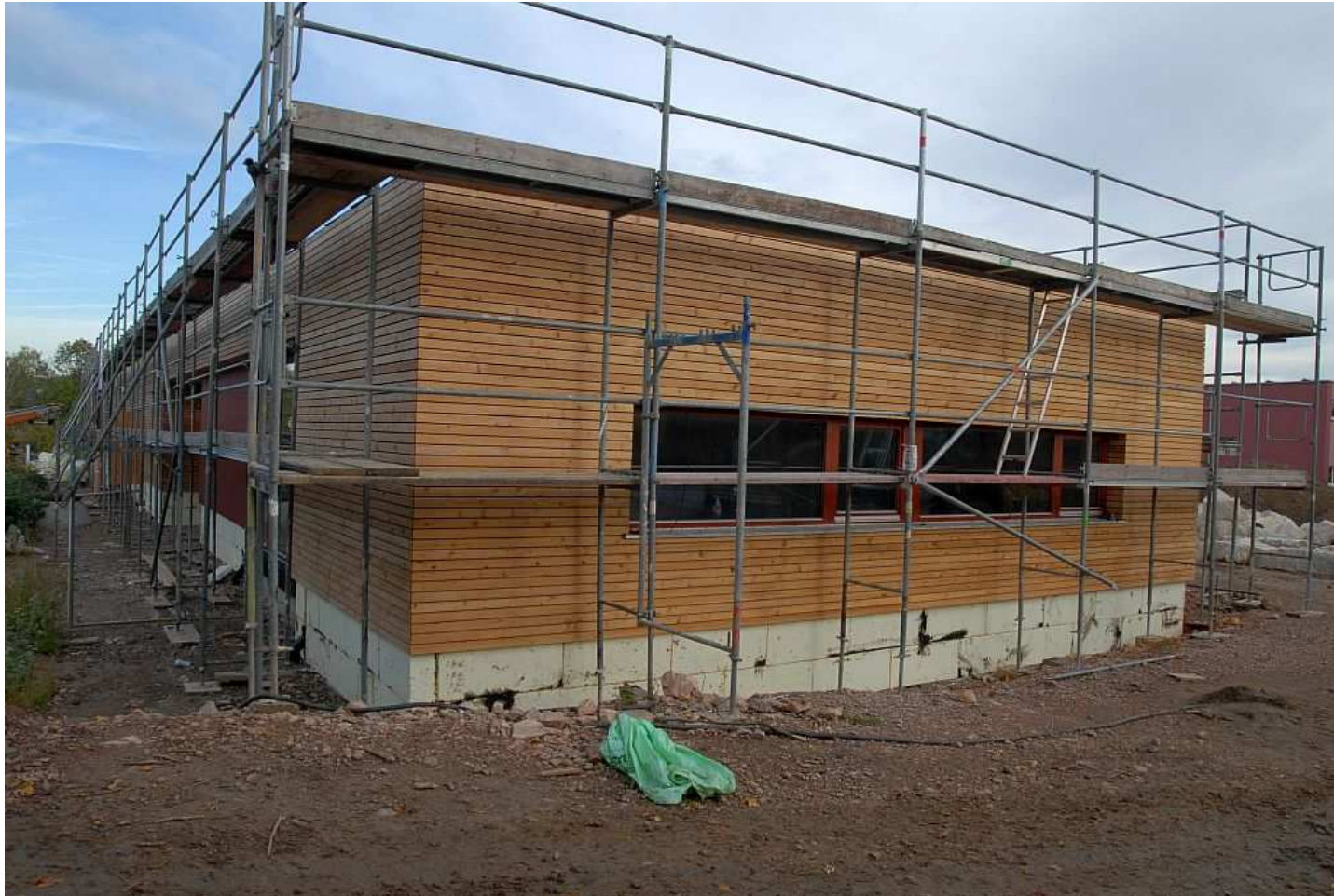
Die Fassade besteht aus horizontal angeordneten, unbehandelten Lärchenholzlamellen, die mit der Zeit natürlich vergrauen und eine silbergraue Optik annehmen.
