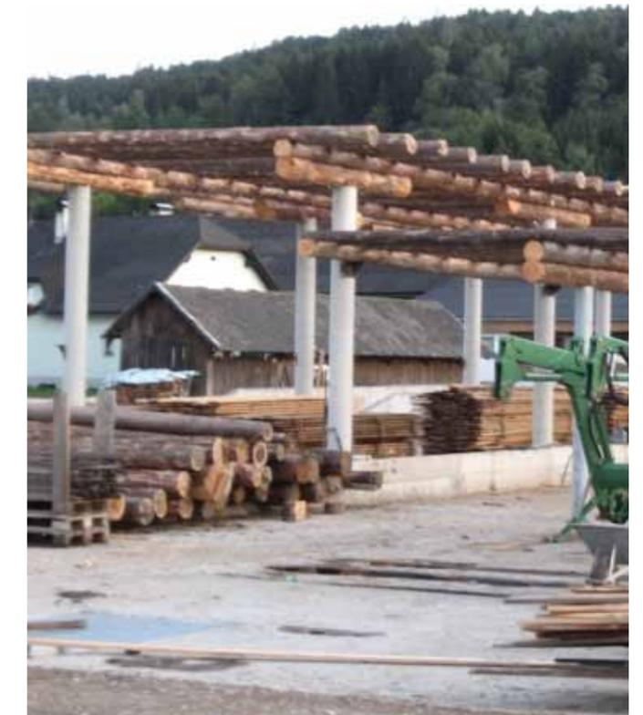
Abb. 9.5 Schleuderbetonrohre als eingespannte Stützen
