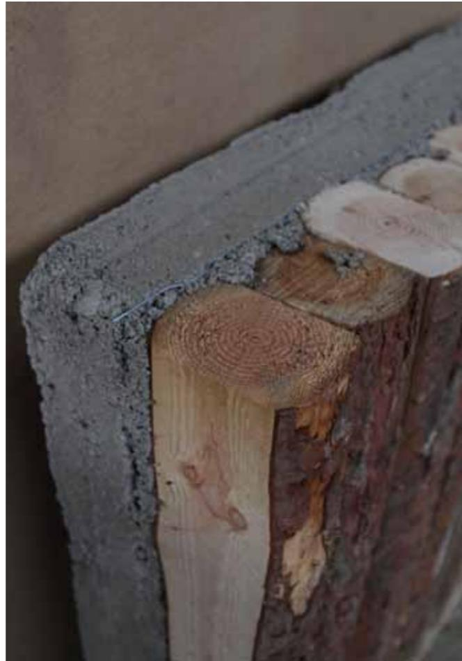
Abb. 47.6 Detail Holz-Beton Verbund
