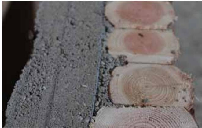
Abb. 45.6 Detail Holz-Beton Verbund
