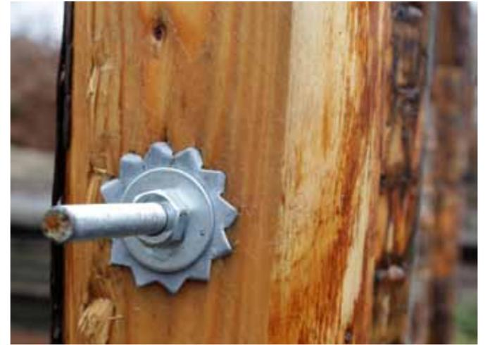
Abb. 19.6 Spannelement
