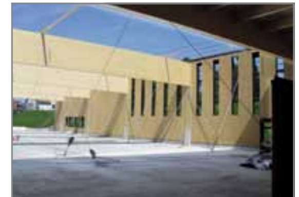
Ing. Holzbau | Sonderbauten
