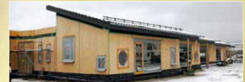
Morbacher Kindertagesstätte in hocheffizienter Brettsperrholzbauweise Architektur- und Ingenieurbüro Jakobs-Fuchs
