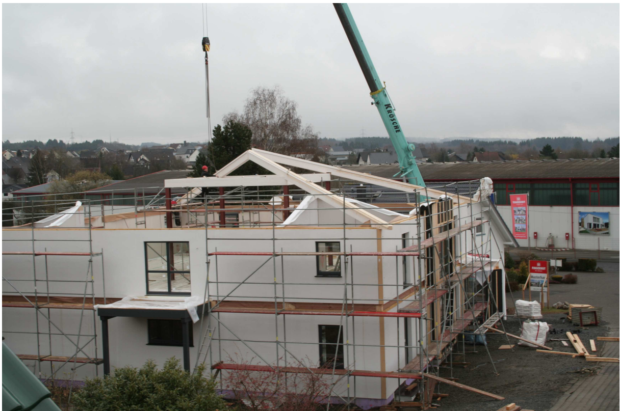
Aufbau des Dachstuhles_Fingerhut Haus Neunkhausen
