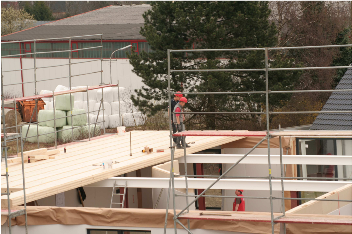
Einbau der Erdgeschossdecke als Vollholzdecke_Fingerhut Haus Neunkhausen
